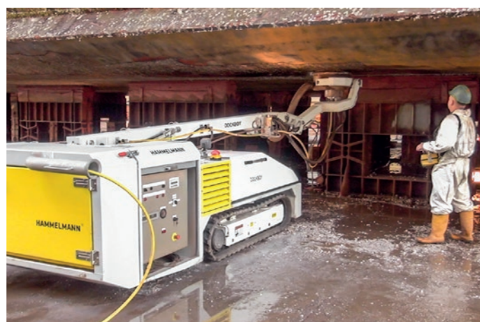
Dockboy – Preparación de superficies en la parte baja del casco del barco
