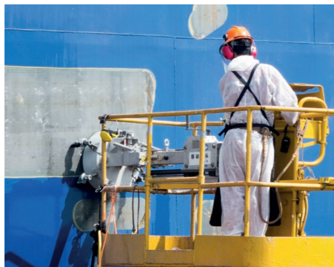
Aquablast Line – Limpieza de zonas especialmente pequeñas
