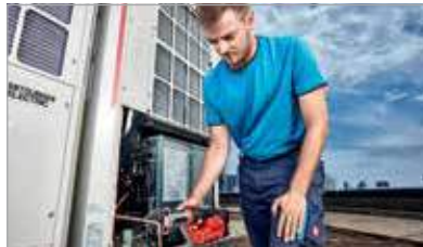
8. Alinee las mandíbulas directamente sobre la conexión y complete la junta
