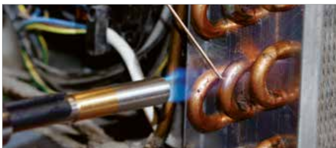
Soldadura fuerte en aire acondicionado y refrigeración
