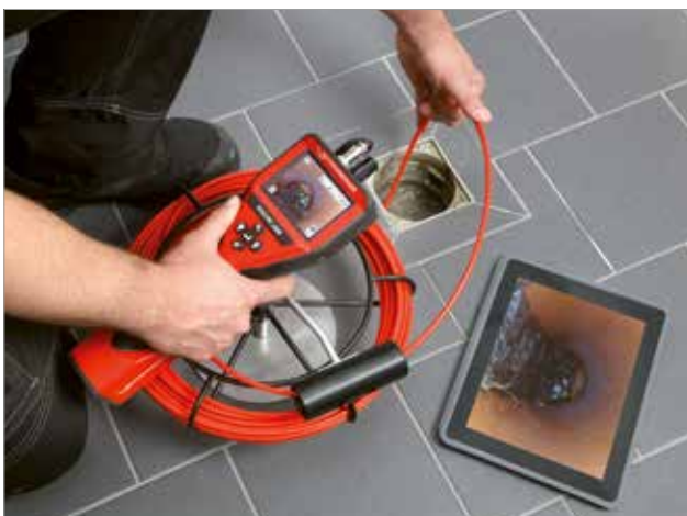
Inspección de drenajes de baños
