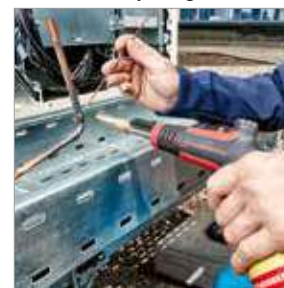
Soldadura fuerte en aire acondicionado y refrigeración
